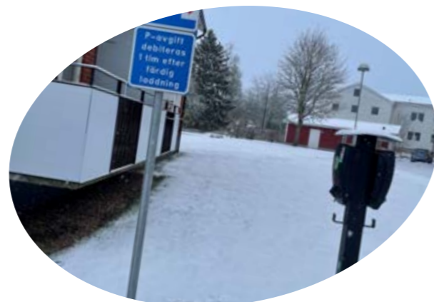
Fortsatt utbyggnation av solceller och laddstolpar
