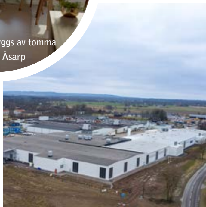
Om- och tillbyggnad Domkraften, Floby
