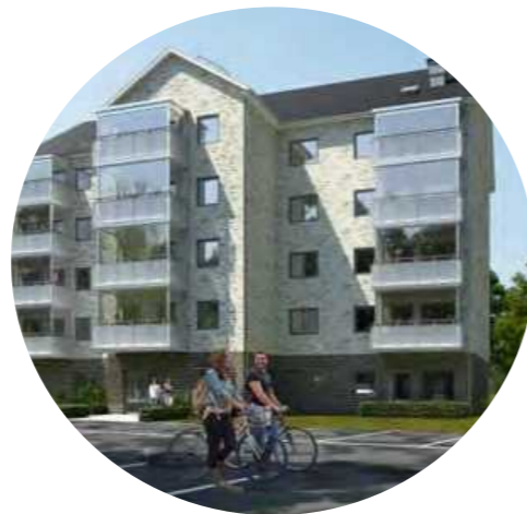
Byggstart Plåtslagaren 38 (22 lgh) och Läkaren 3 (LSS + 23 lgh)
