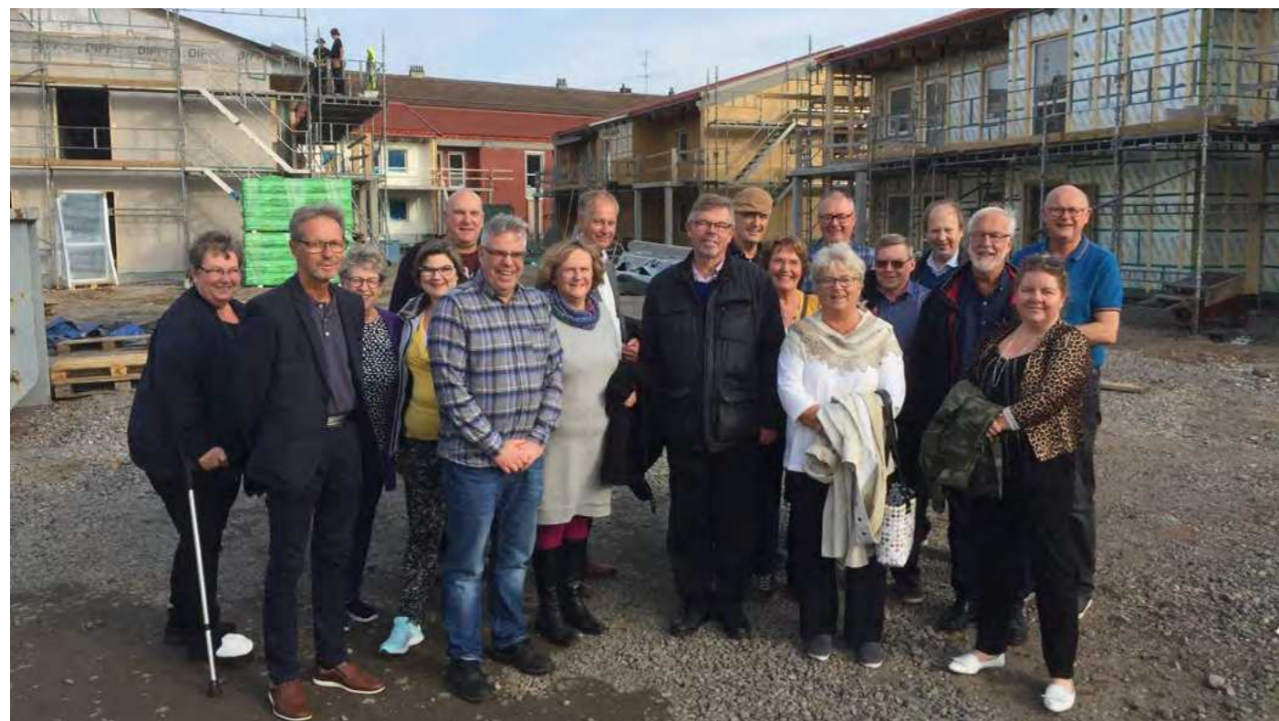
Styrelsen på studiebesök vid bygget på Plåtslagaren 38.
