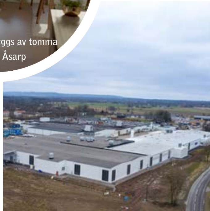
Om- och tillbyggnad Domkraften, Floby
